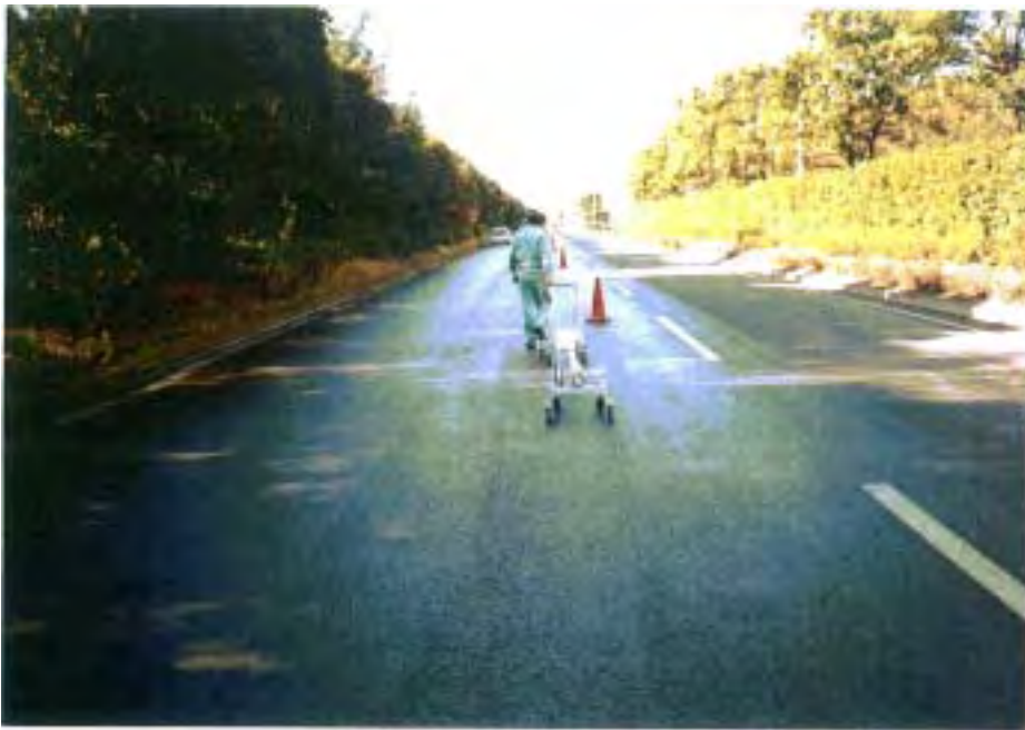
平坦性測定状況
