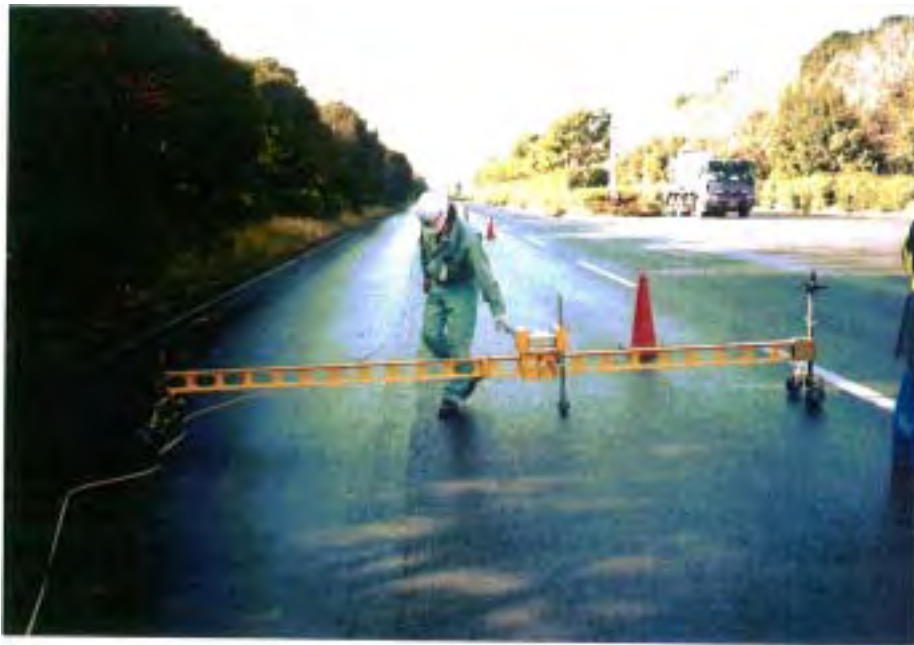
わだち掘れ測定状況
